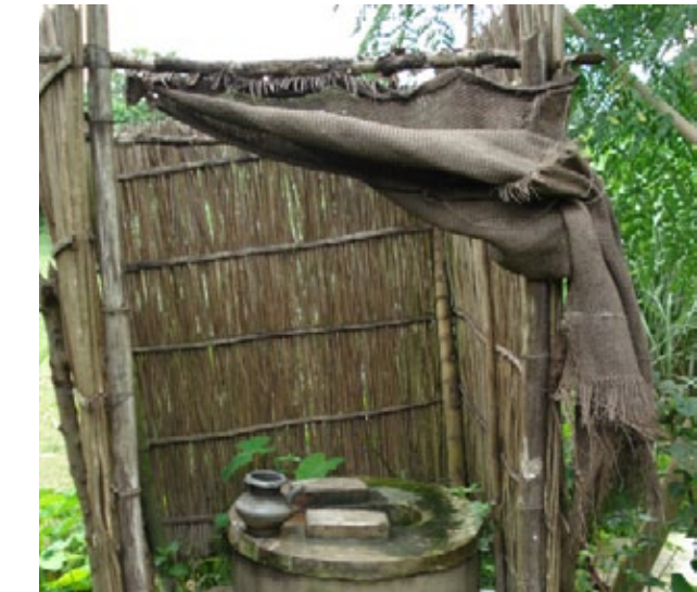
Figure 15: Single pit with pour flush toilet
